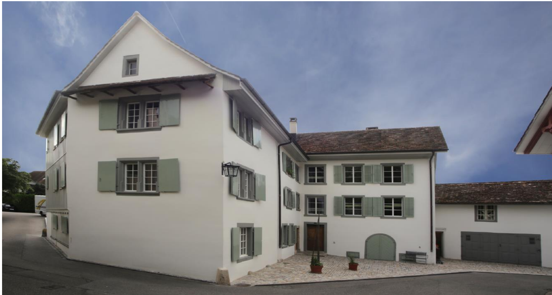
Ancien Moulin de Sissach, avec façade rénoverée au moyen d'un crépi isolant Aérogel
