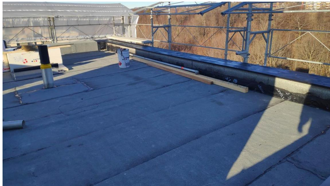
– Hauteur de la remontée d'étanchéité selon SIA 271 à respecter
